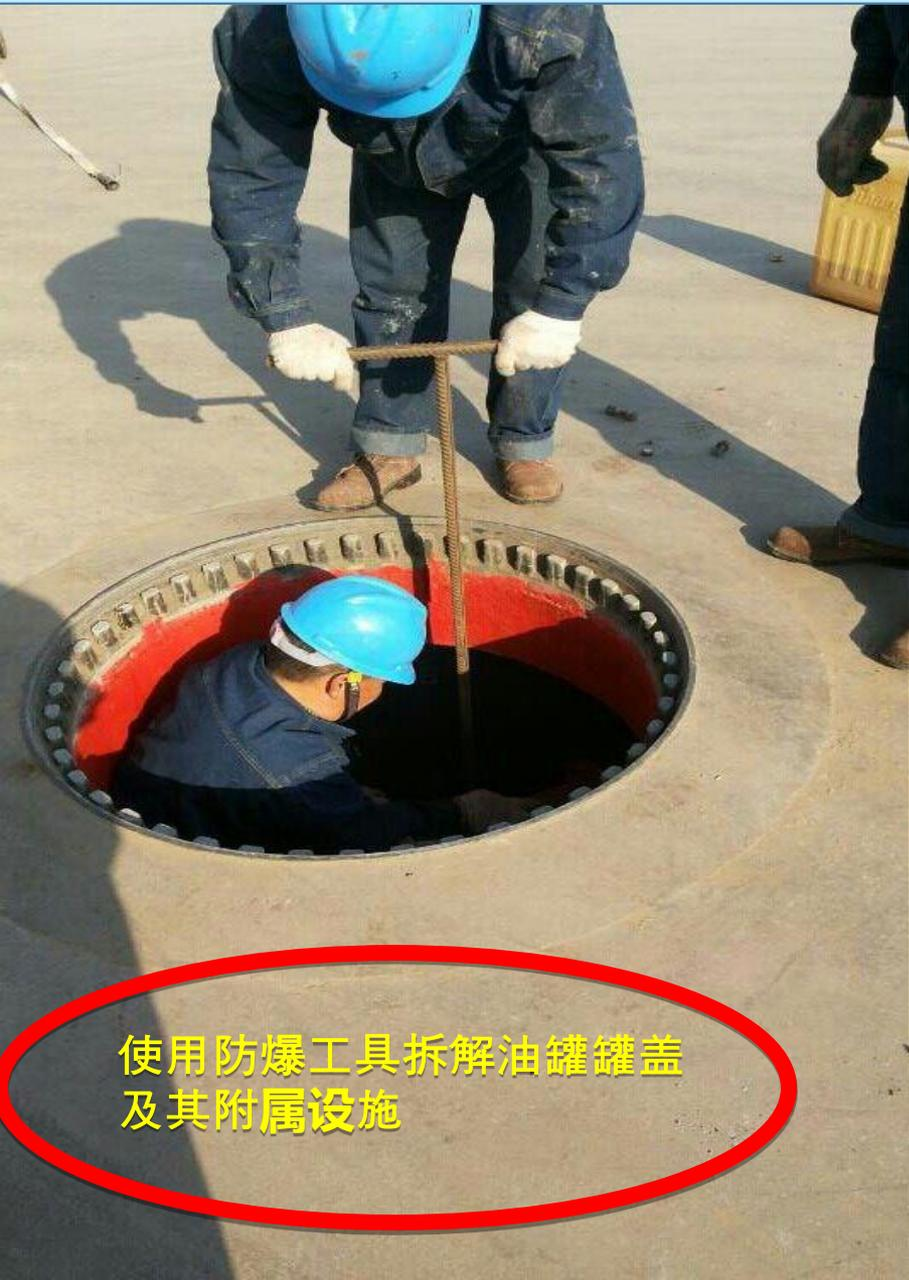
使用防爆工具拆解油罐罐盖
