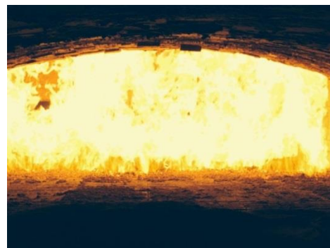
后部裸露的炉排，残碳，漏风
