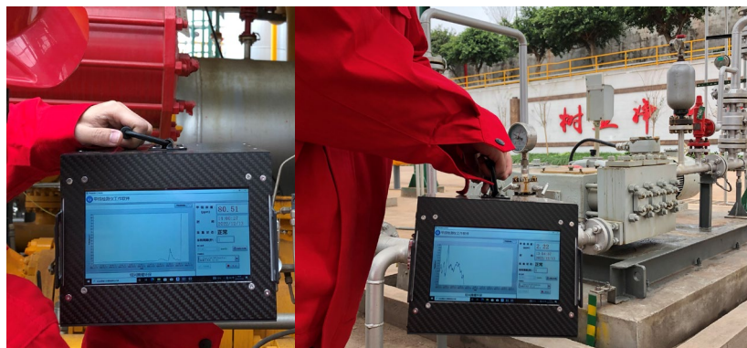
场站组件逸散点检测
